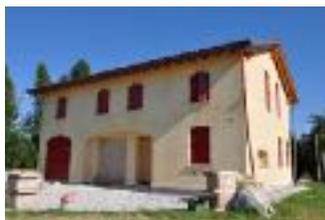
Natural Beton: cemento naturale, ottenuto combinando meccanicamente truciolo vegetale di canapa con un legante a base di calce (edifici realizzati a Vicenza)
